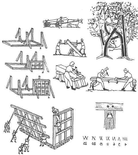
英国の木造家屋の建築の様子 (外壁の飾曲り材の木取りなど)
