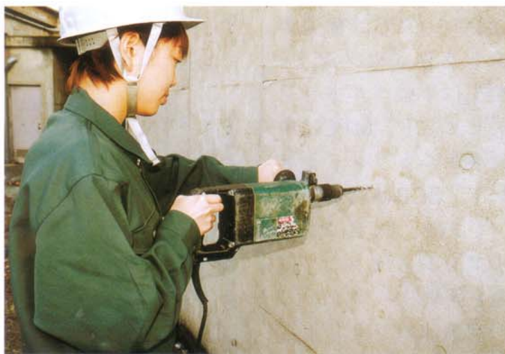
写真-1 ドリル削孔の状況
