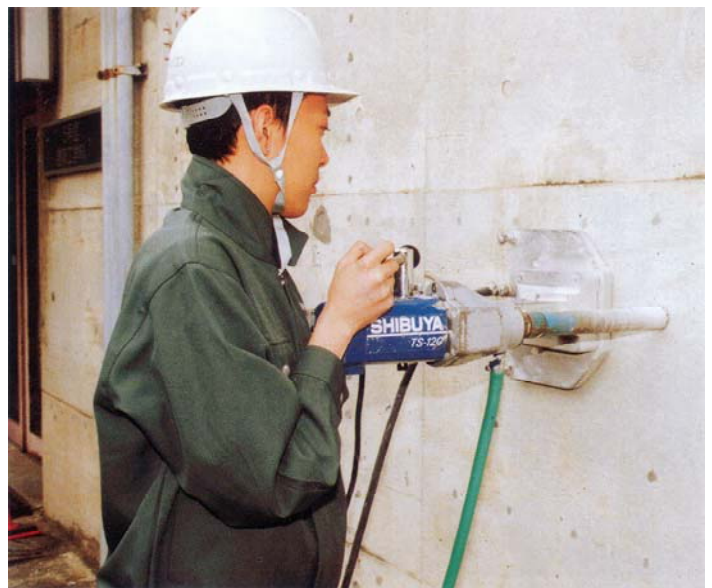
写真-1 コアマシンによるコンクリートコアの採取状況
