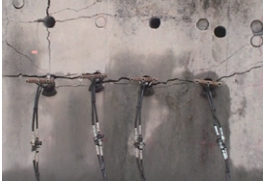
「ロックバスター」による破碎状況
