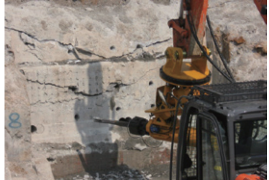
「スーパーウェッジ」による破碎状況
