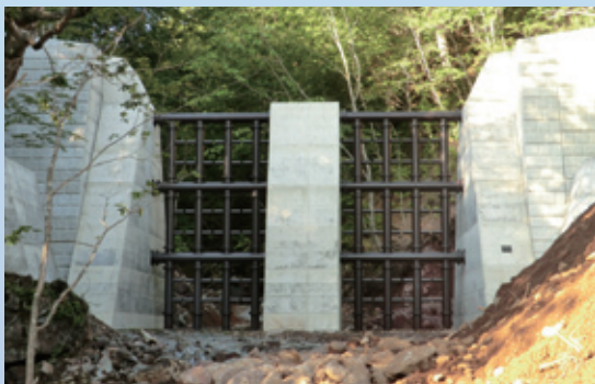
(写真:日鐵住金建材(株))
