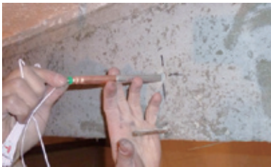
写真：(株) 相模工業 「ミニブラスティング工法」
