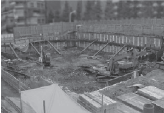
ビル解体工事での施工
