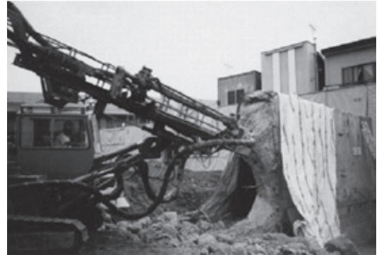
鉄筋コンクリート擁壁解体工事での施工
