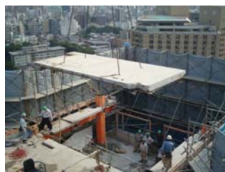
—切断した床版荷上げ—
