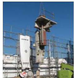
—切断CFT柱 荷上げ状況—
