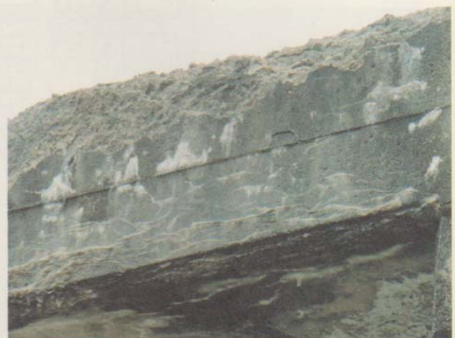
凍結融解作用を受けた構造物のひび割れとスケーリングの例
