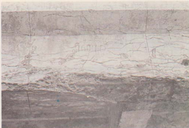
凍結融解作用を受けた構造物のひび割れとスケーリングの例
