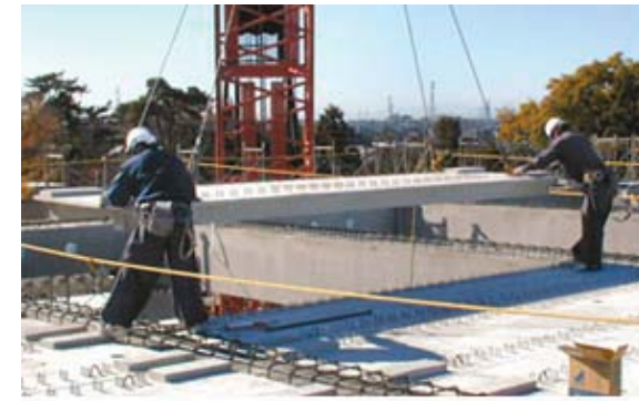
PC合成床版敷設状況
