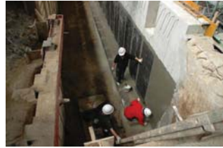
改質アスファルトシート防水 トーチ工法 エチレン酢酸ビニル樹脂系シート防水
