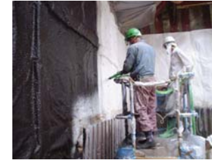
改質アスファルト系塗膜 防水吹付け工法
